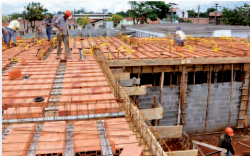
Construção da UPA
