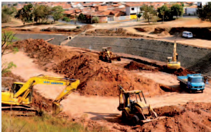
Obras no Inocoop
