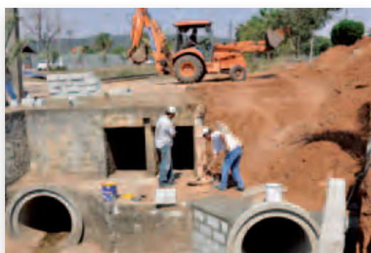
Obra de Galeria na Avenida 11
