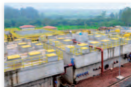
Estação de Tratamento de Esgoto do Jd. Conduitta
