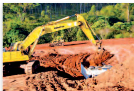
Construção do novo fórum
